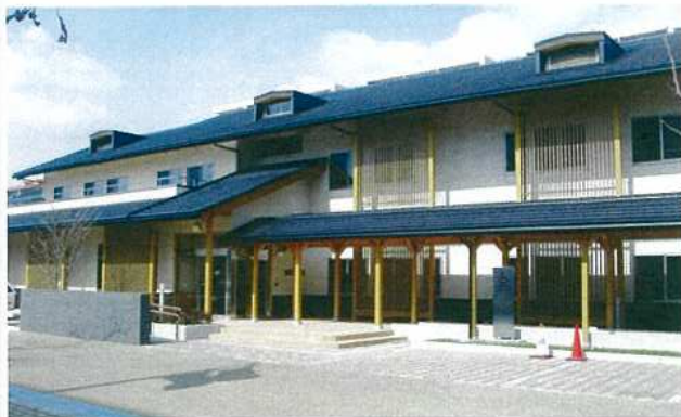
県立の木造施設
